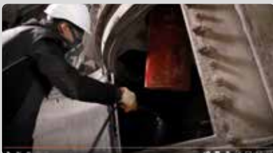
BETONEX - Ochrona mieszalnika
