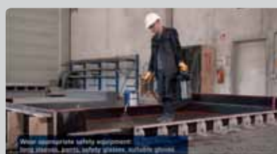
Aplikace separačních prostředků na beton
