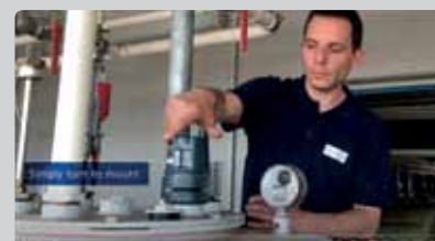
SmartLevel: Monitorování hladin v nádržích
