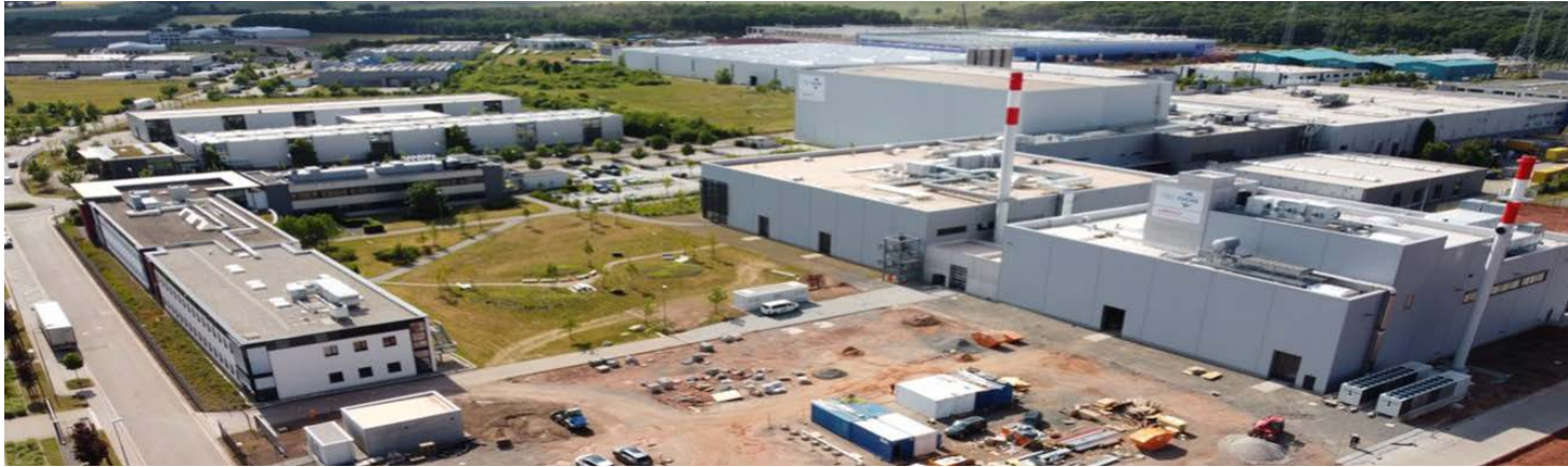
Kaiserslautern, D – PU-Fettanlage
